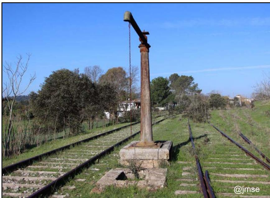
A unos 300 metros antes de llegar al edificio de la estación, encontramos una bellísima bomba de agua, realizada completamente en hierro forjado y utilizada para llenar los depósitos de las locomotoras a vapor que circulaban por esta línea. El agua la llegaba a través de unas tuberías que cruzaban las vías por debajo, aproximadamente un metro por debajo de ellas y proveniente de un depósito, ubicado a su derecha y a unos tres metros por encima del
