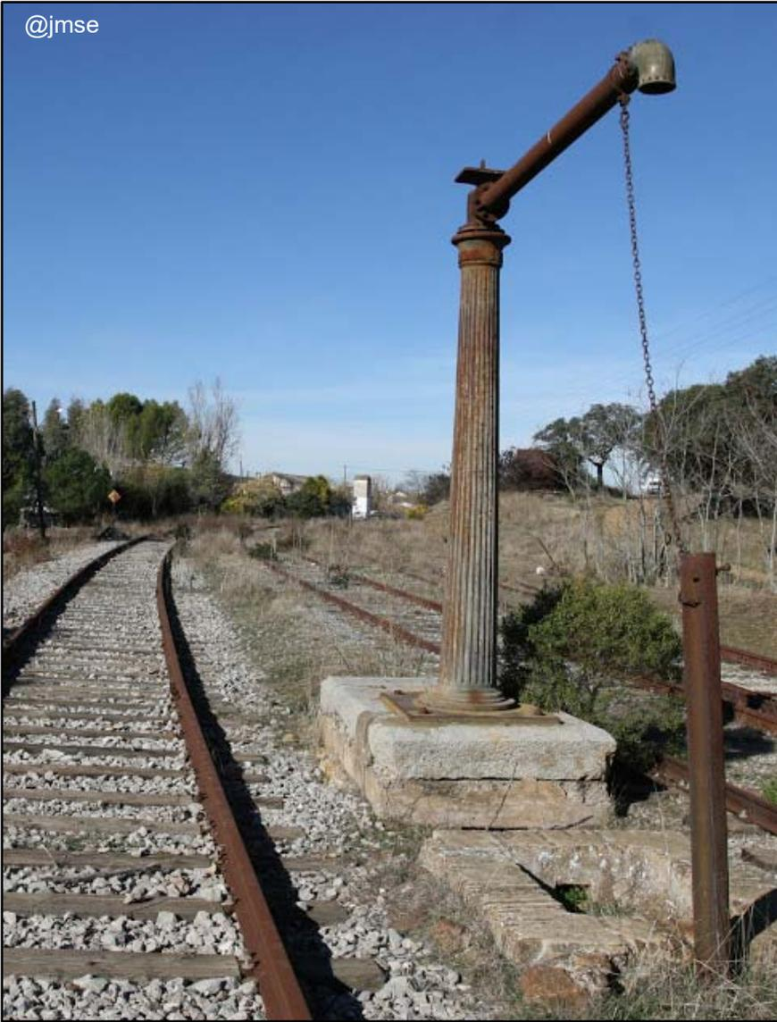
Imagen de otra de las bombas de agua con las que contaba la infraestructura de la estación. Al igual que la anterior, está fabricada íntegramente en hierro forjado hace siglo y medio.
