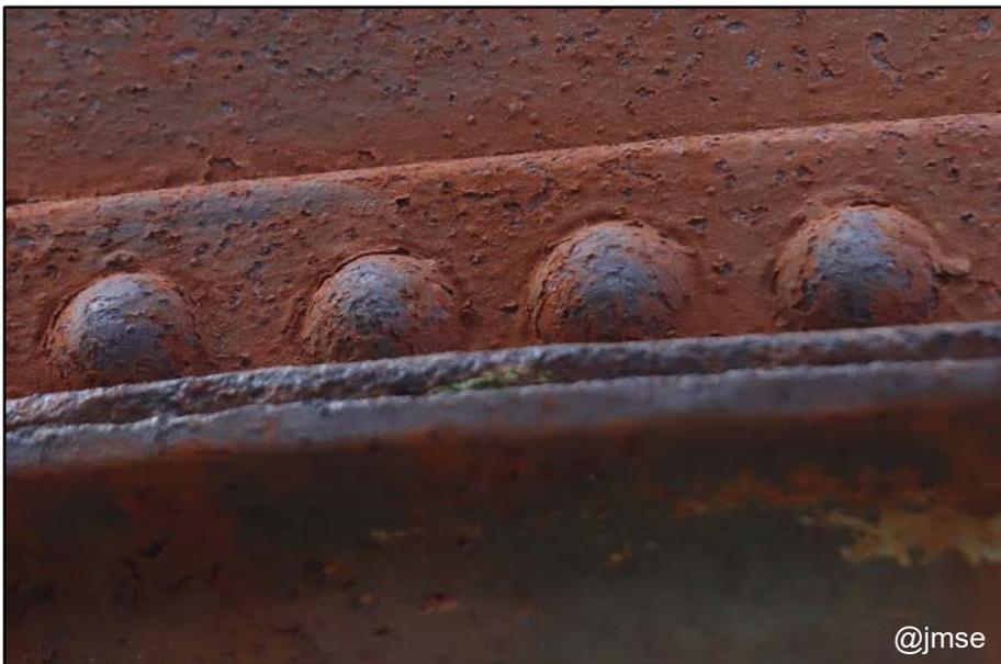
Detalle en primer plano de cuatro de los muy abundantes remaches que rodean toda la circunferencia del segundo depósito de agua en su zona baja, justo por encima del entramado metálico de sujeción al suelo que constituye su base, reforzando enormemente su solidez. Puede apreciarse como el trabajo artesanal de forja en caliente, realizado hace casi 150 años, de modo completamente manual insertando los roblones al rojo vivo en cada orificio correspondiente, ha hecho que cada remache se
