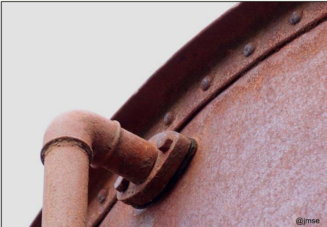
Punto de acoplamiento entre el cubato del segundo depósito de agua y la zona superior del tubo antirebosamiento.
