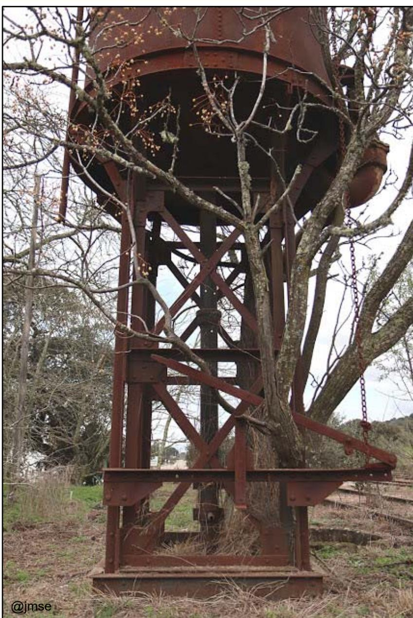
Foto izquierda: Otra foto en detalle de la zona inferior del segundo depósito de la antigua estación de tren de Obejo y de su zona de sujeción al suelo. A la derecha de la imagen se aprecia la cadena que servía para girar el surtidor de agua hacia las vías.
