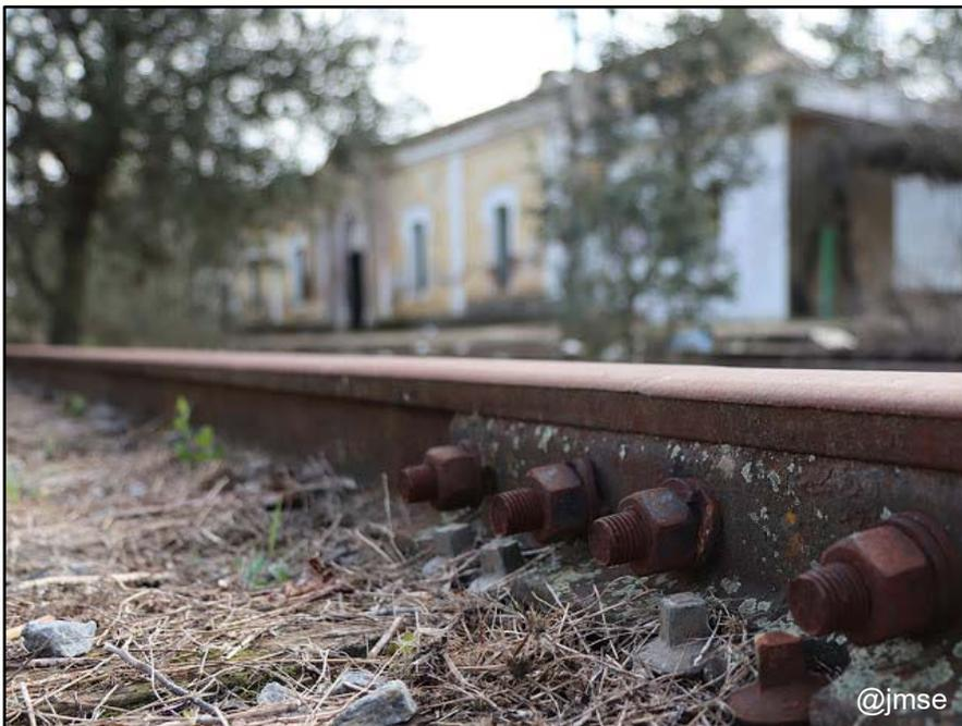
Foto izquierda: tuercas de refuerzo de rail en un tramo de vía de la línea férrea Córdoba-Almorchón a su paso por la antigua estación de tren de Obejo, visible al fondo de la imagen.
