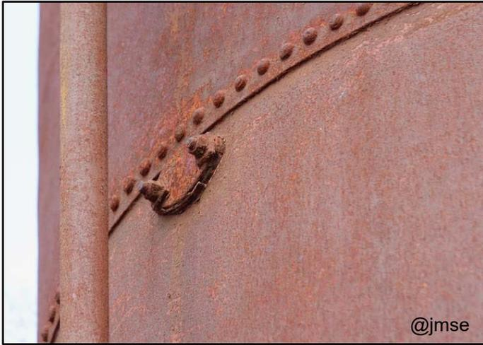
Foto izquierda: ampliación del área en la que a principios de los años setenta se puso un parche sobre una pequeña fisura que apareció en un punto del cubato del segundo depósito de agua, tras cien años de funcionamiento.
