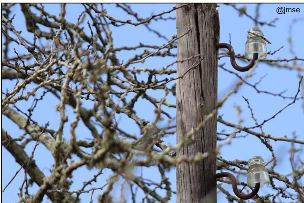
Detalle de zona superior de otro poste de luz ubicado en las proximidades de la estación, donde se aprecian los típicos aislantes de cristal de este tipo de postes.
