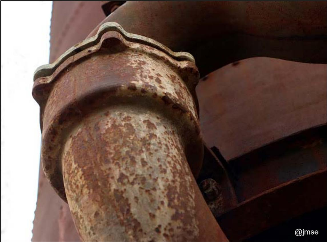
Detalle de la robusta tubería con abrazaderas que va desde el segundo depósito de agua hasta el surtidor.
