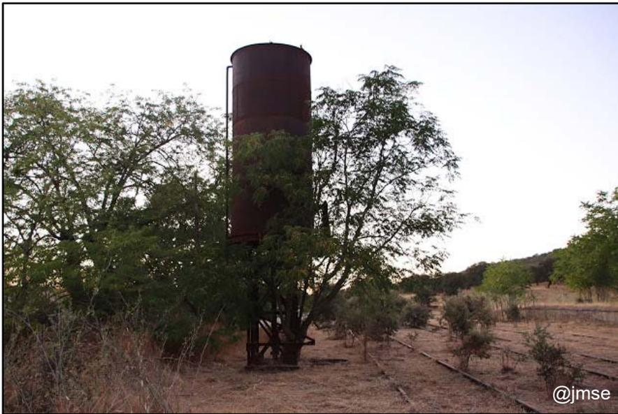
Segundo depósito de agua, con forma de cubato cilíndrico soportado por estructura metálica reforzada con remaches, dotado con surtidor y ubicado aproximadamente a 50 metros, en dirección hacia El Vacar y Villaharta. Está a la izquierda de la vía férrea Córdoba-Almorchón.
