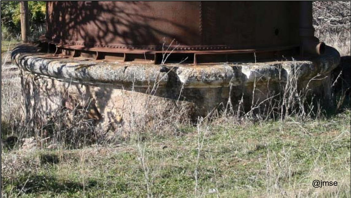
Detalle de la zona inferior del mismo depósito de agua, en la que puede observarse la sólida base circular de piedra sobre la que descansa, así como la ingente cantidad de remaches que fortalecen el perímetro de la zona baja de la estructura, en sinergia con otra hilera de roblones que une dos planchas de metal justo encima.
