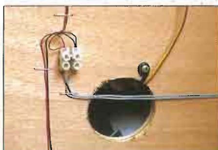
Bajo. En caso necesario puede agrupar varias conexiones en un borne común con los hilos grises.
